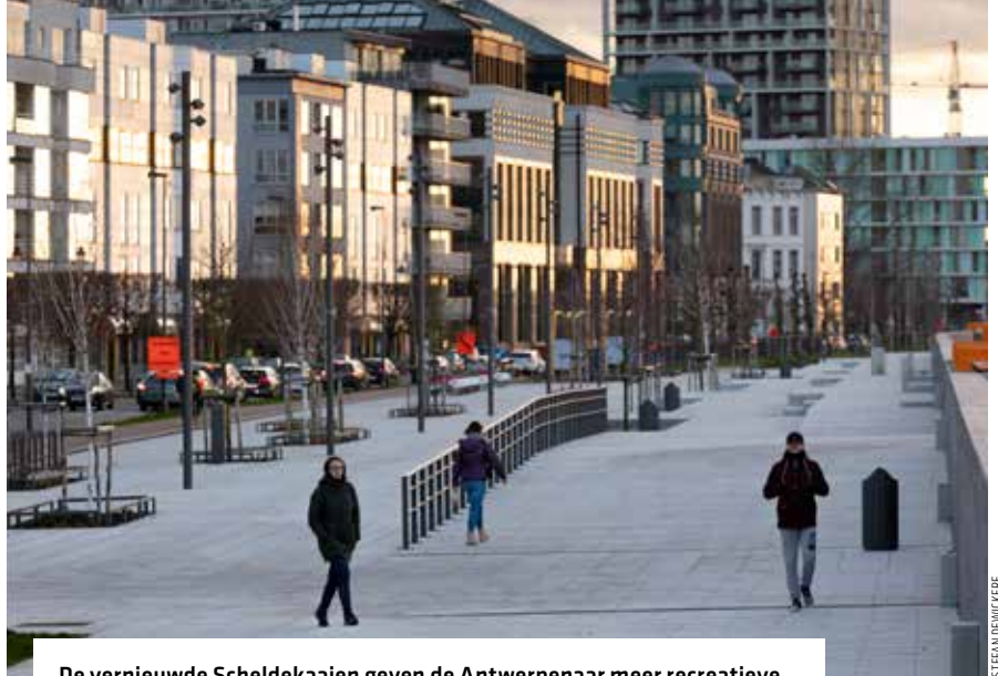
De vernieuwde Scheldekaaien geven de Antwerpenaar meer recreatieve ruimte en een betere bescherming tegen het wassende Scheldewater.
